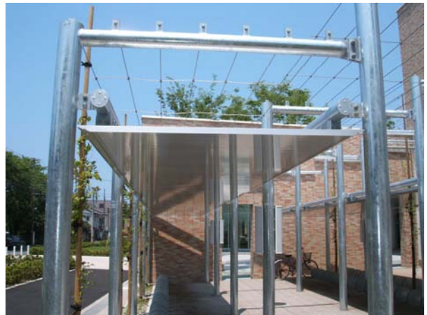
駐輪場庇 パネル
